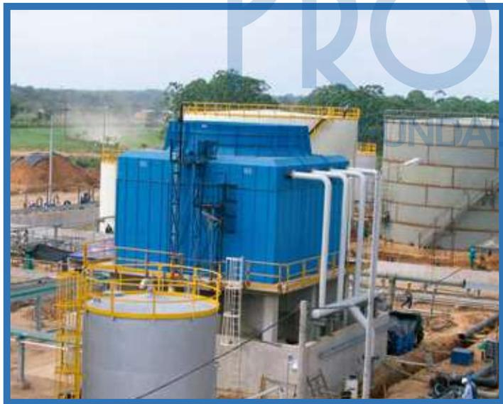
Las torres PROTON son equipos de alta confiabilidad y evitan costosas paradas por mantenimiento. Su diseño de tiro inducido en contraflujo, además de sus ventiladores de bajo peso y cuello aerodinámico, permiten un bajo consumo de energía.
